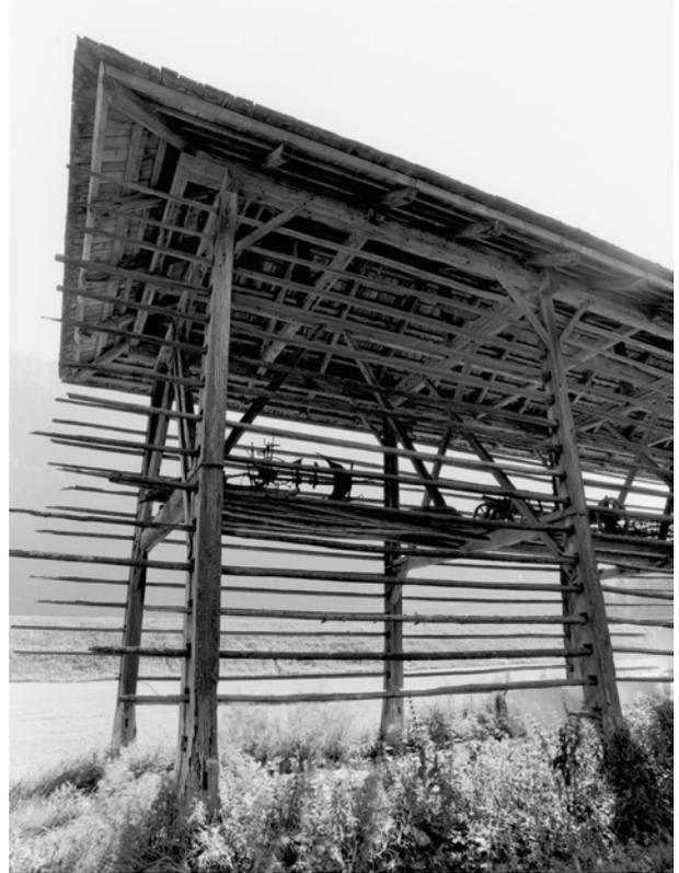
Abb. 4: Diese Getreideharfe aus dem Iseltal (A) gibt Einblick in alle Details ihres konstruktiven Aufbaus.
